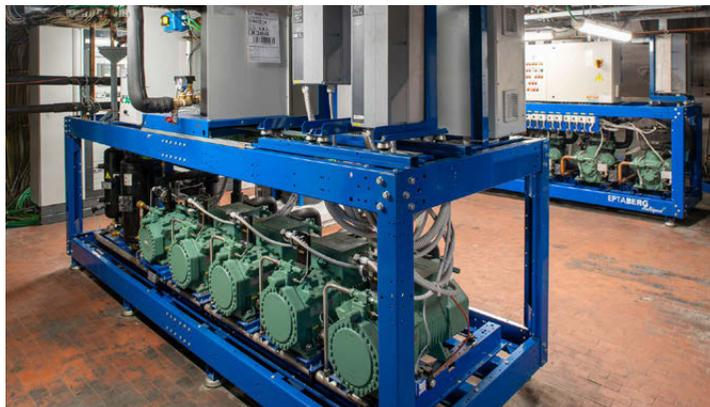
Il progetto realizzato con Epta presso il punto vendita di Bologna permetterà di valutare le prestazioni dell'FTE Full Transcritical Efficiency e delle altre innovazioni installate all'interno dell'ipermercato, in una zona climatica che presenta temperature estive elevate. Secondo le prime proiezioni l'impianto di Bologna, rispetto ad uno sviluppato con HFC, assicurerà un risparmio di 35.868 kWh/anno, pari a
